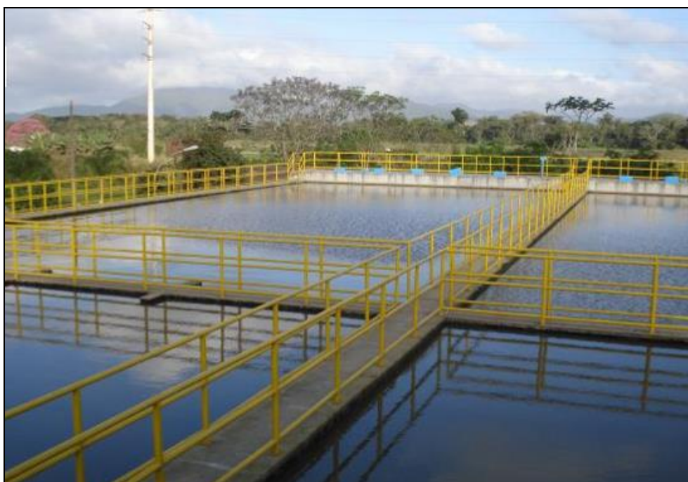
Figura 92. Estação de Tratamento São Roque, da SEMASA, Itajaí, SC.
