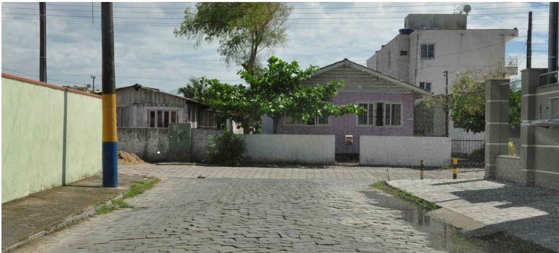
Foto 35 – Cruzamento – Rua José Tiago da Costa com a Rua Perciliana Rodrigues Gaya
