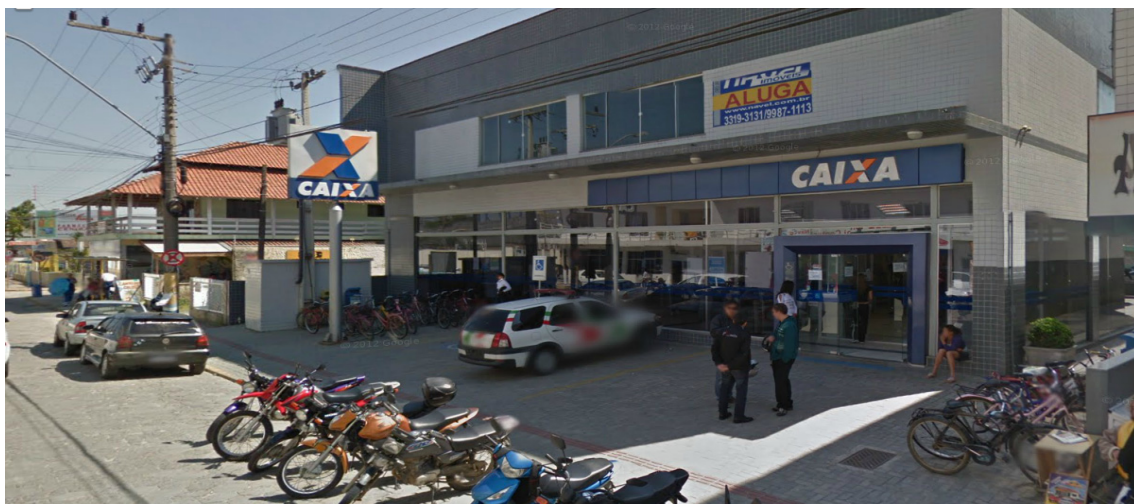
Foto 44 – Fachada da Agência da Caixa Econômica Federal – fachada para a avenida Conselheiro João Gaya.
