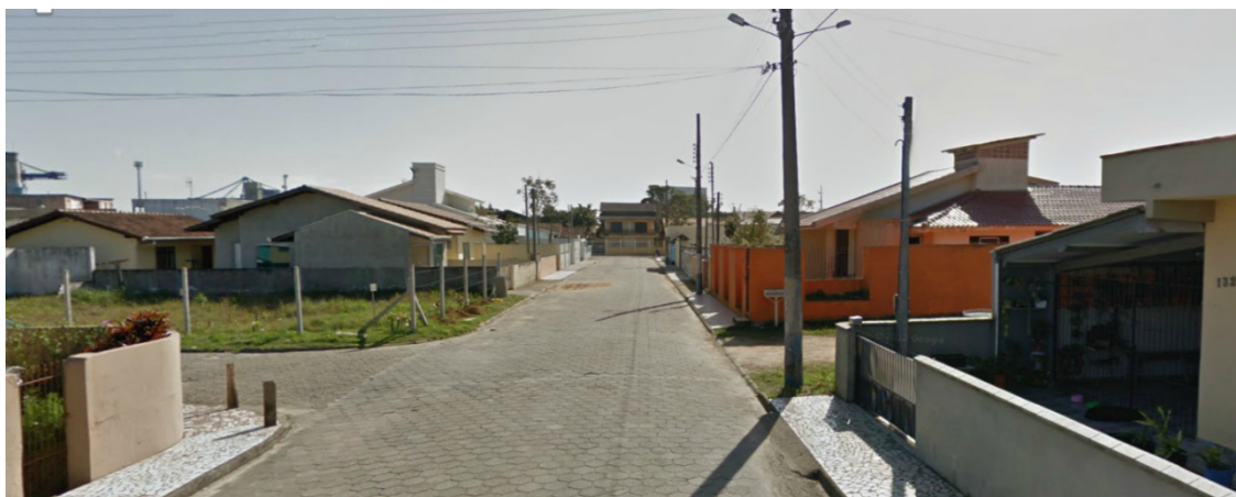
Foto 13 - Rua José Honório Vieira cruzamento com Rua Maria da Costa
