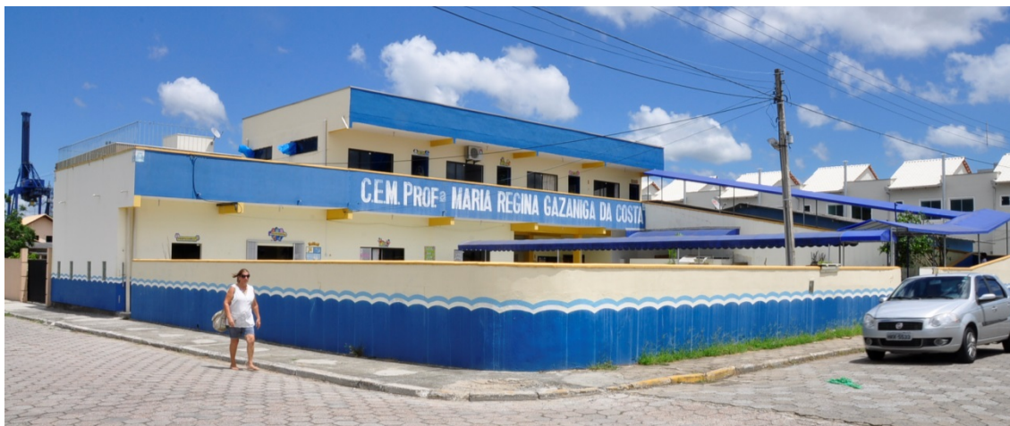
Foto 46 – Fachada – Centro Educacional Municipal Prof a . Maria Regina Gazaniga da Costa, localizado no cruzamento entre a Rua José Tiago da Costa e Ricardo Mafra.
