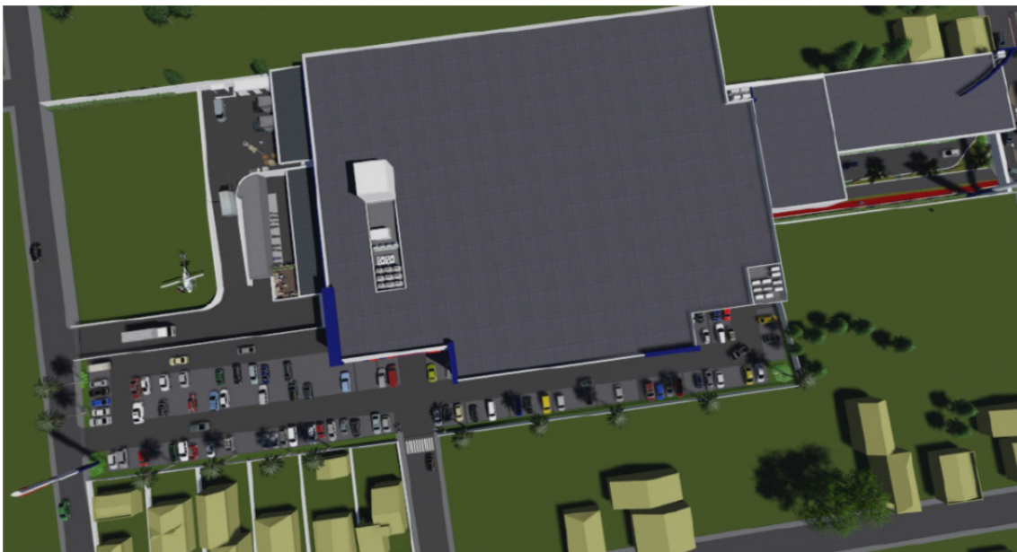
Figura 67 – Vista superior da área a ser ocupada pelo empreendimento.
