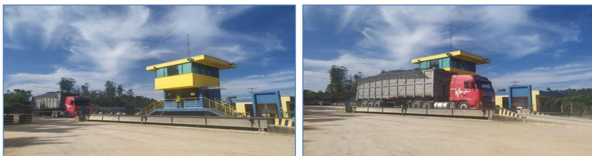
O sistema conta ainda com a instalação de célula fotoelétrica para identificação de veículos e sistema de filmagem dos veículos pesados, além de sistema de proteção contra descargas elétricas. O prédio da balança foi edificado sob área coberta com sala operacional para controle das pesagens e sanitário interno.
