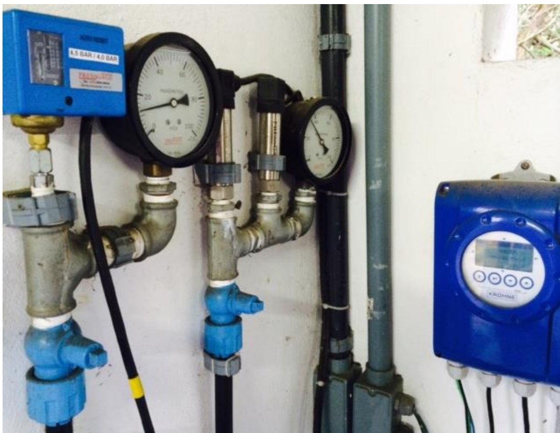
FOTO 6: REGISTRADOR DE VAZÃO E MANÔMETROS - SÃO DOMINGOS
