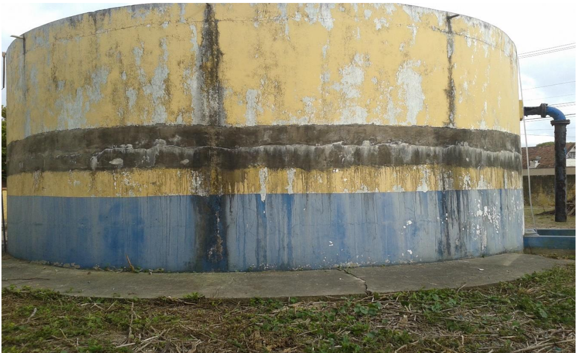
FOTO 12: VISTA GERAL COM DETALHE DA INFILTRAÇÃO DO RESERVATORIO DA MEIA PRAIA
