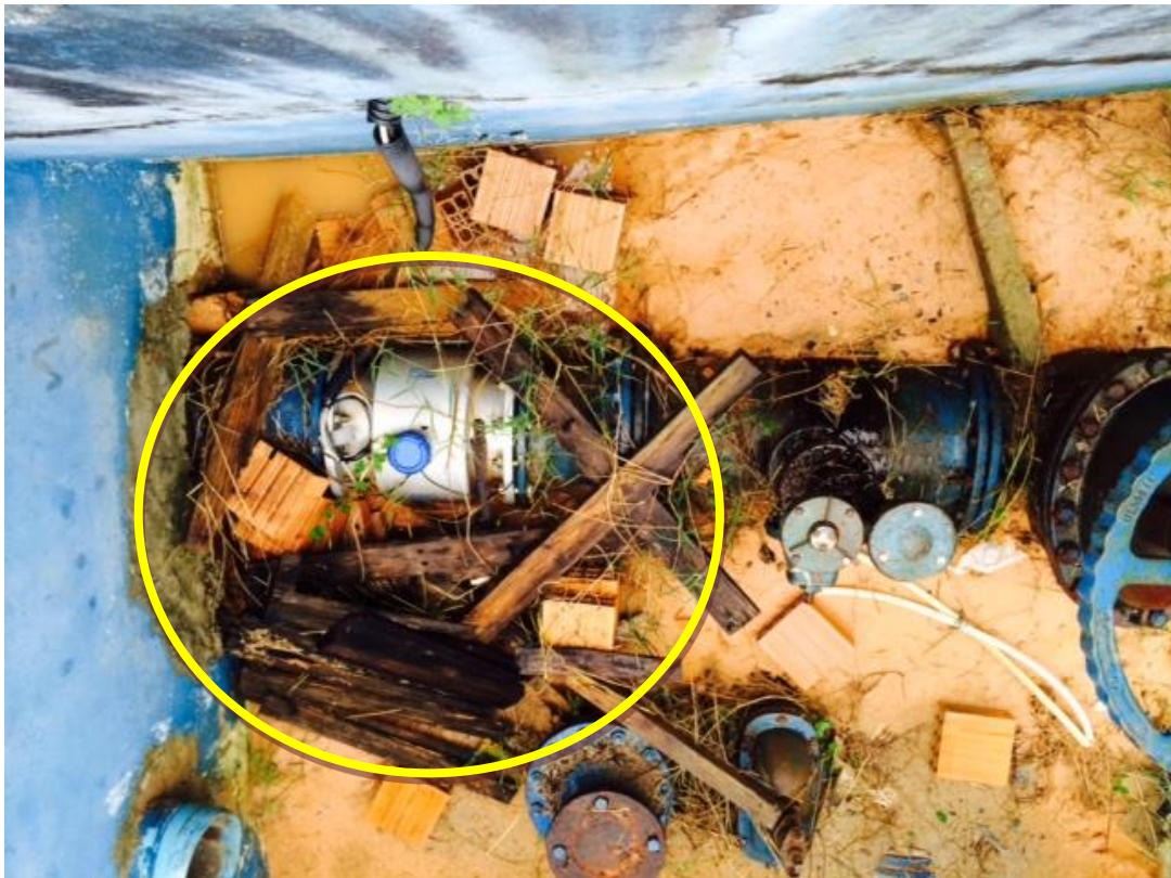
FOTO 6: REGISTRADOR DE VAZÃO E MANÔMETROS - SÃO DOMINGOS
