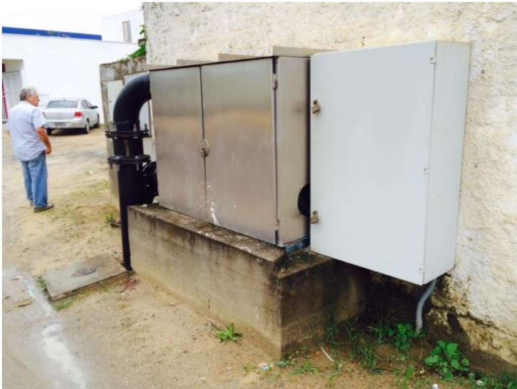
FOTO 22: CONJUNTO MOTOBOMBA DE RECALQUE – TRAVESSIA 1
