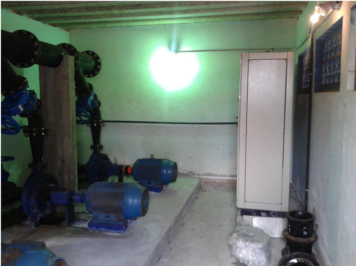
FOTO 14: CONJUNTOS MOTOBOMBAS DE RECALQUE E PAINEL ELÉTRICO - RESERVATORIO DA MEIA PRAIA
