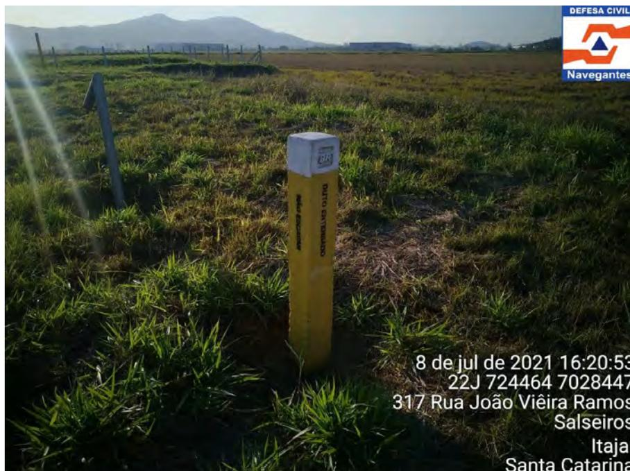
Foto 02: Pilarete indicando/alertando sobre o local de passagem do duto da Petrobras.
