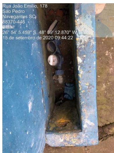
Figura 39 - Torneira junto com o hidrômetro.
