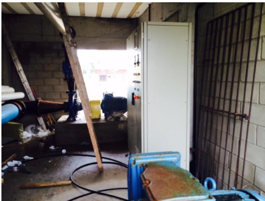
FOTO 18: CONJUNTOS MOTOBOMBAS DE RECALQUE - RESERVATORIO AEROPORTO 2000 m 3
