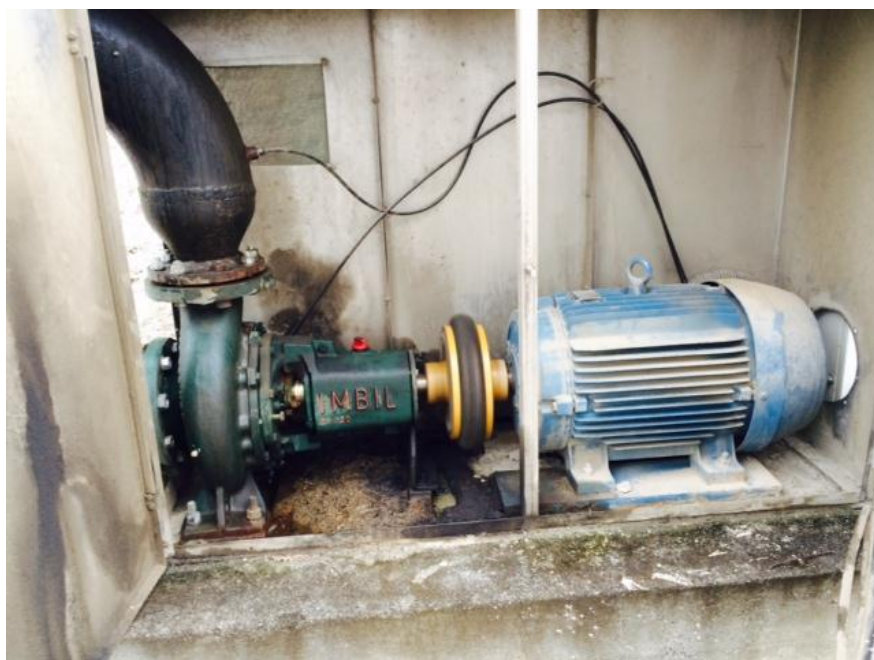
FOTO 22: CONJUNTO MOTOBOMBA DE RECALQUE – TRAVESSIA 1
