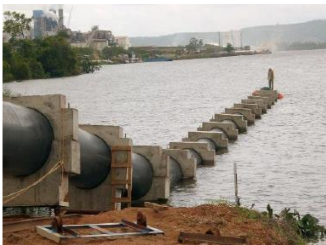
Foto 3: Exemplo de estrutura para tubulação submersa em PEAD.
