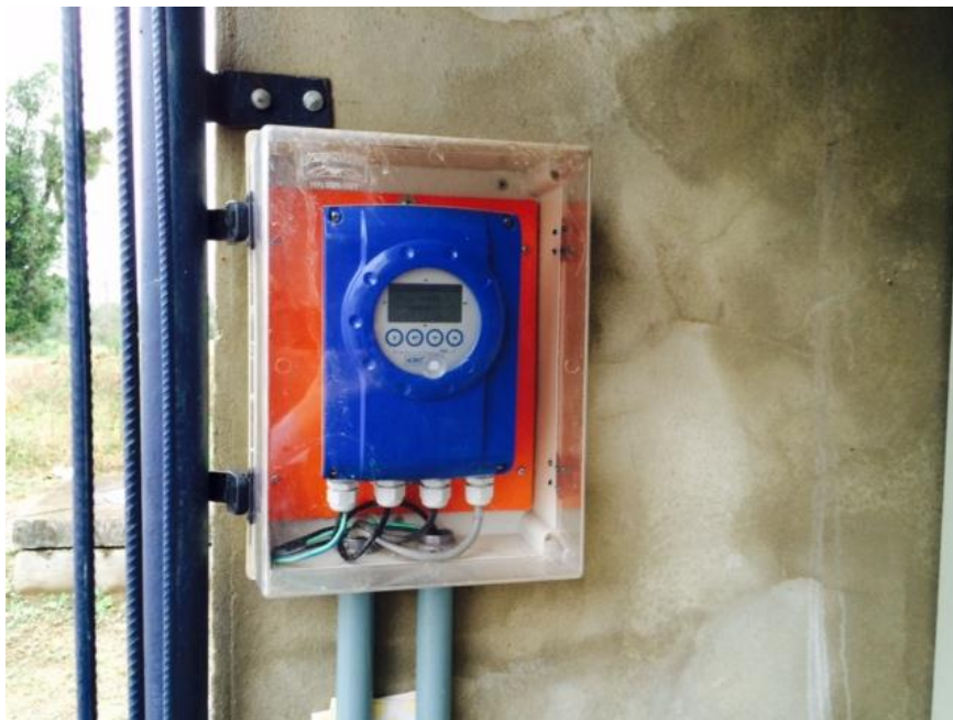
FOTO 23: REGISTRADOR DE VAZÃO – TRAVESSIA 1
