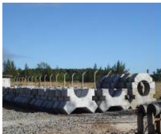
Foto 4: Exemplo de estrutura de ancoragem.
