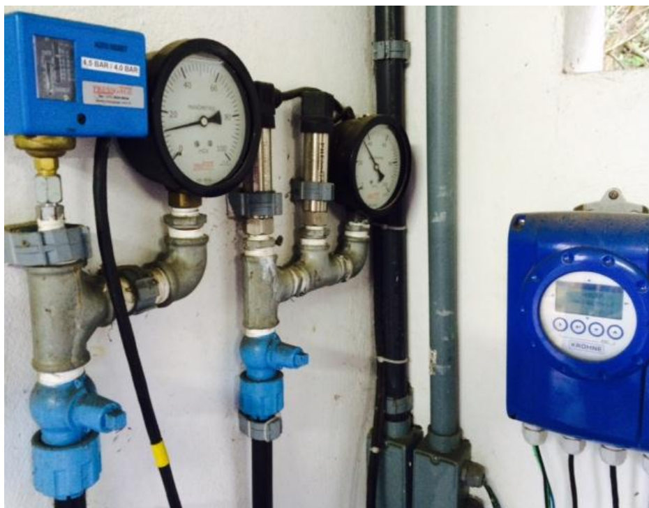
FOTO 6: REGISTRADOR DE VAZÃO E MANÔMETROS - SÃO DOMINGOS
