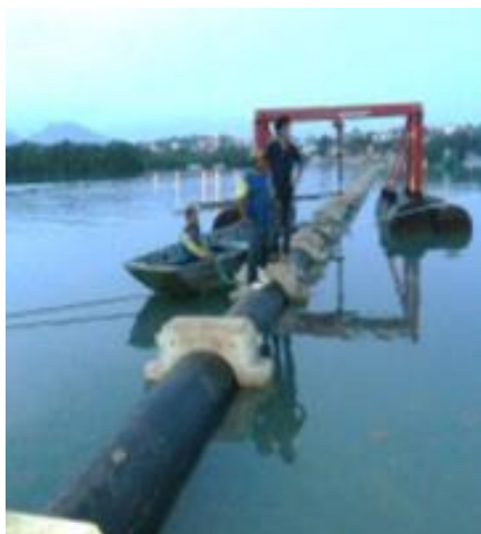
Foto 5: Exemplo de procedimento de lançamento da rede submersa em PEAD.
