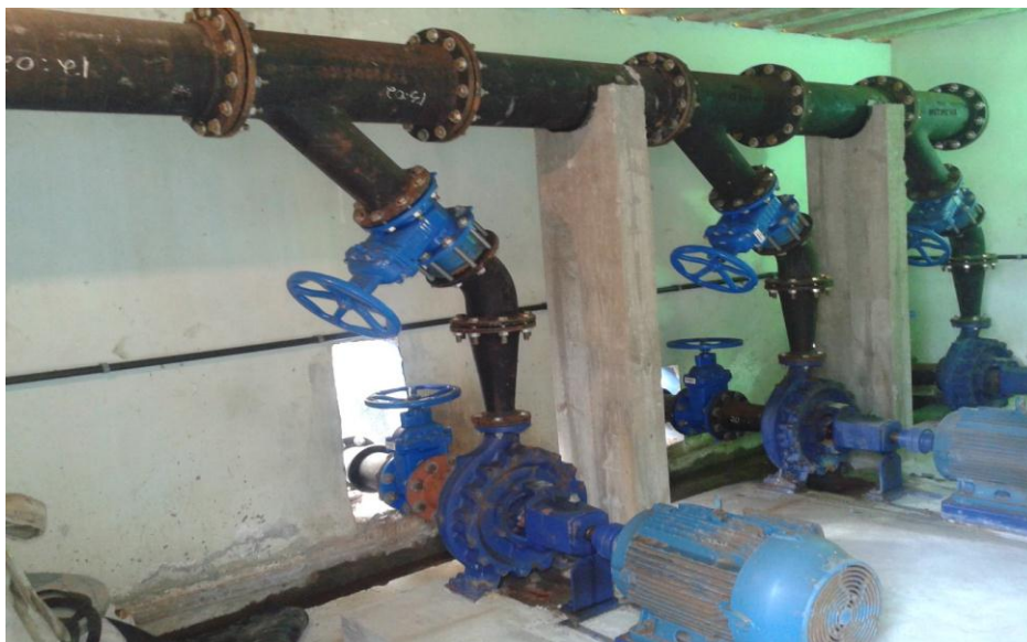
FOTO 13: CONJUNTOS MOTOBOMBAS DE RECALQUE - RESERVATORIO DA MEIA PRAIA
